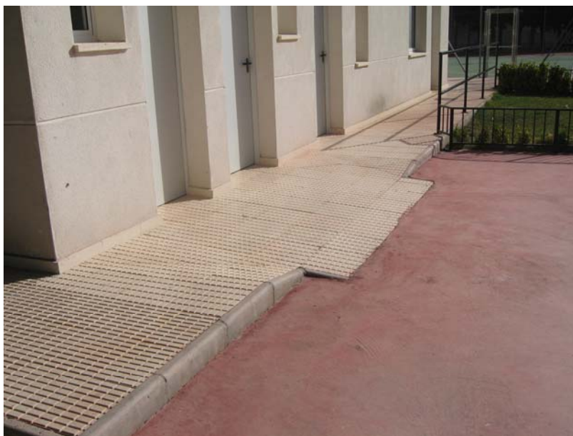
FOTOS DE ACERA PERIMETRAL (PRIMERA ZONA)
