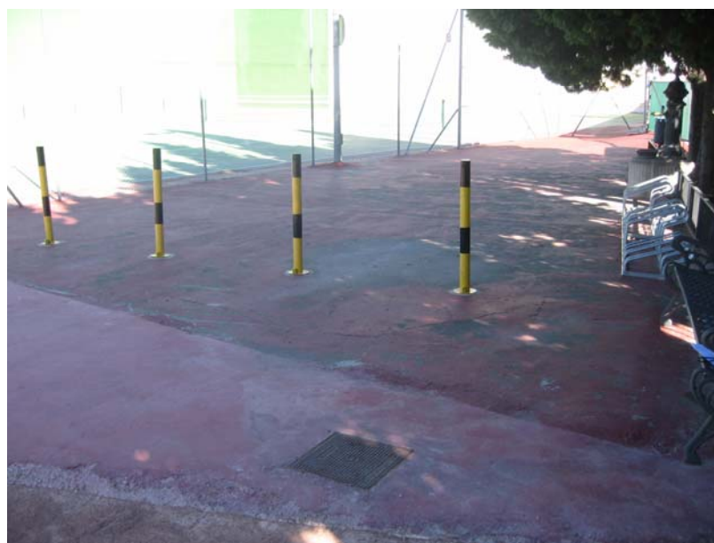
FOTO DE ACCESO AL PASILLO ENTRADA (PRIMERA ZONA)
