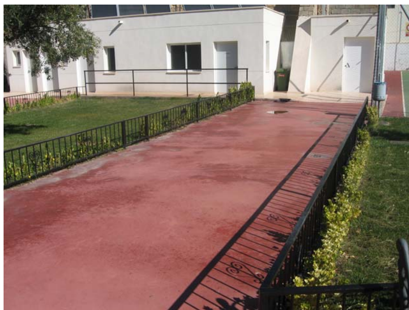
FOTOS DE PASILLO DE ACCESO HACIA VESTUARIOS (PRIMERA ZONA)
