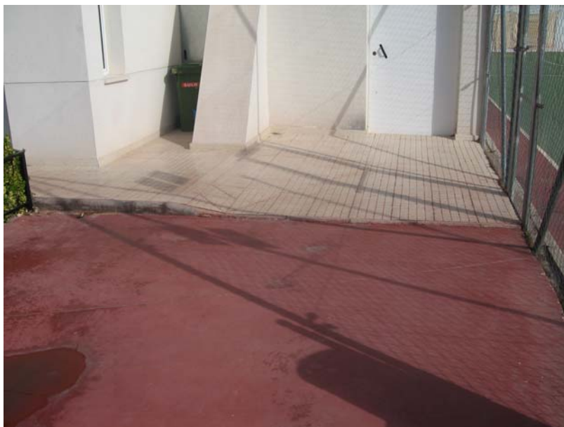
FOTOS DE VADOS ACERA PERIMETRAL (PRIMERA ZONA)
