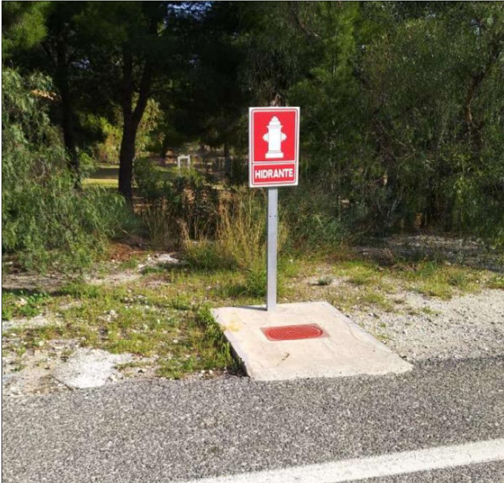
*Ilustración 18: Hidrante Existente y correctamente señalado.*
